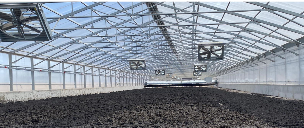
NADOR WWTP, MOROCCO
